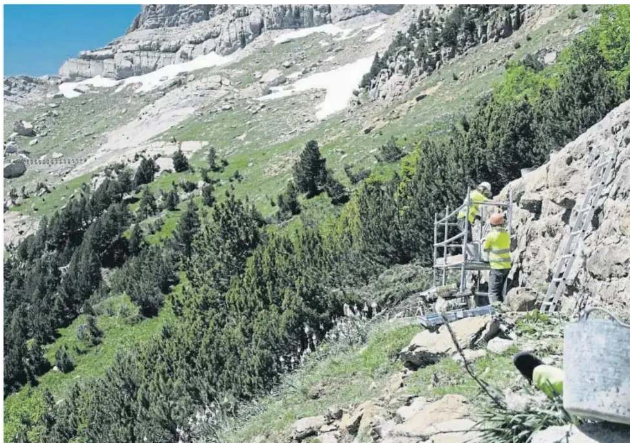
Los operarios trabajan en el refuerzo de uno de los muros de contención construidos en la pendiente de la montaña
